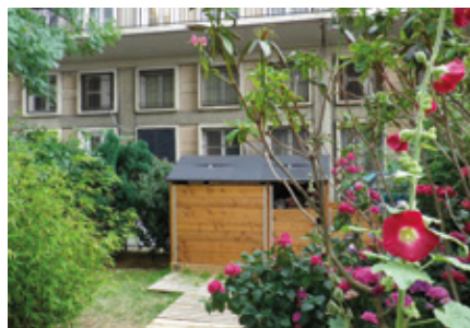
Un pavillon de compostage est installé par la CODAH au pied des immeubles.
