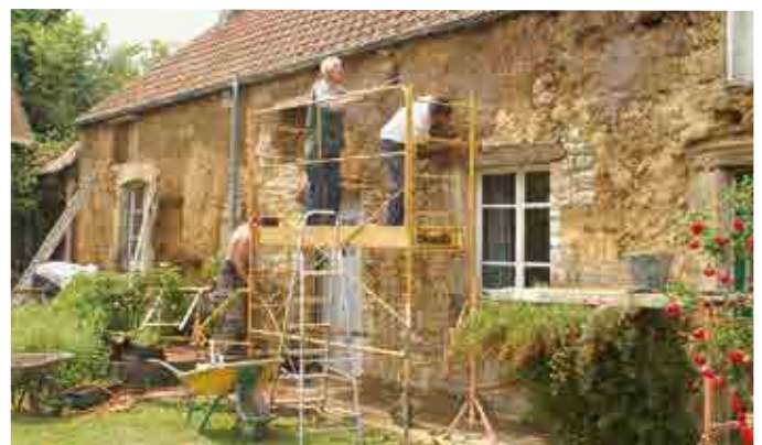
Réhabilitation «EnerTERRE» dans le Parc des Marais du Cotentin.
