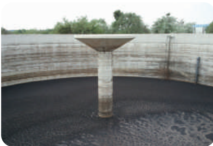
② Fosse de stockage du digestat liquide
