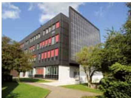
Panneaux solaires au bâtiment Lemery Crédit photo : Eric Benard - ADEME
