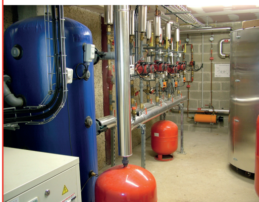
Installation d'une PAC eau/eau à la base de Léry-Poses
