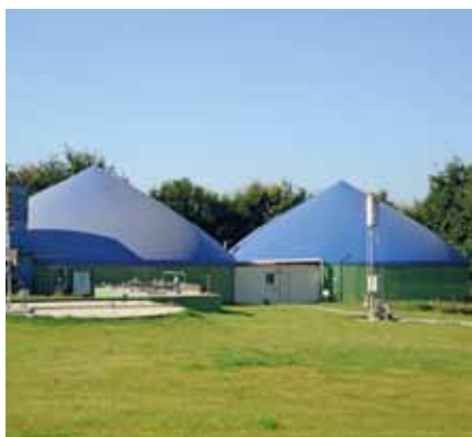
Le digesteur et le post-digesteur : au cœur du procédé.
